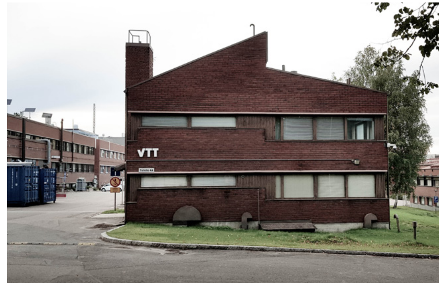
Asemakaavassa suojeltu rakennus säilyy.
